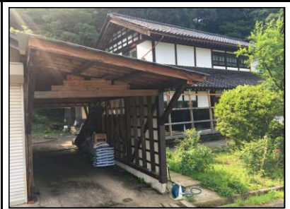
車庫(シャッター無しの部分)
