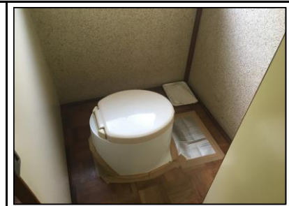
トイレ(大便器)
