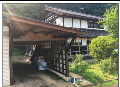
車庫(シャッター無しの部分)
