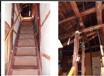
階段と天井の梁(2階)
