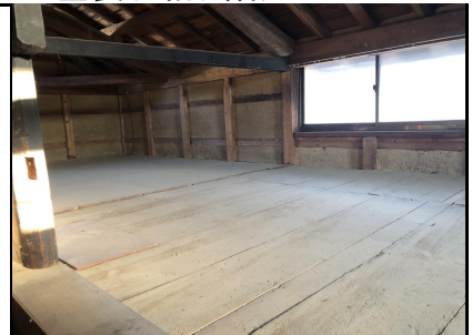
小屋裏収納(3階)
