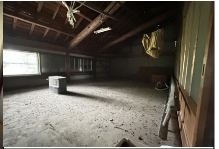
屋根裏収納(2階)
