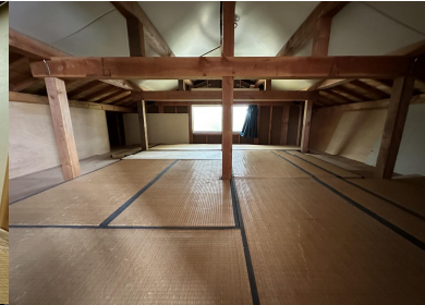
小屋裏収納(2階)
